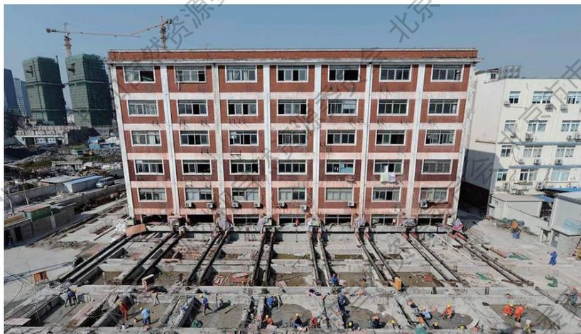
图4 基建筑整体平移工程
