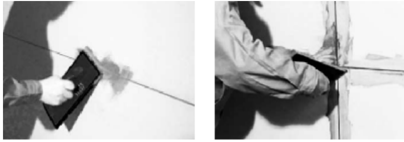
填缝剂施工
