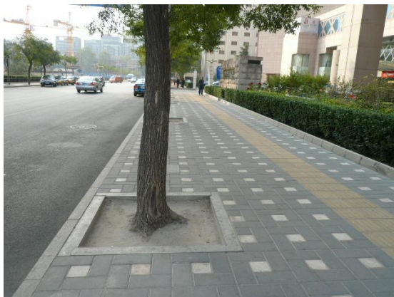
图 4-12 树池紧贴路缘石的案例
